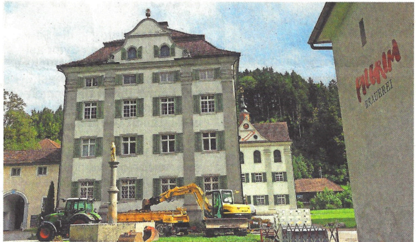
Erweiterungsarbeiten der PILGRIM Brauerei in Fischingen
